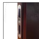
zaczep w skrzydle drzwiowym biernym
